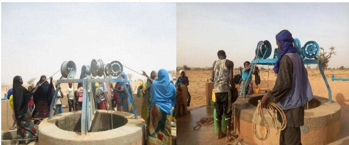
Photo 5 et 6 : Puits cimentés multi-usages
